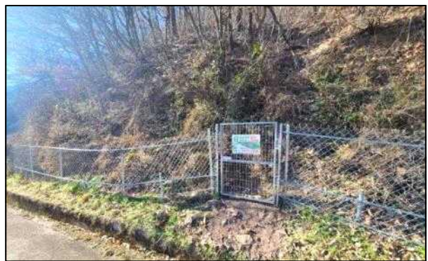
< 울타리 내 출입문 신규 설치 >
