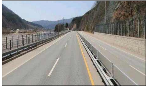
<낙석방지망과 ASF울타리 중복 설치>
