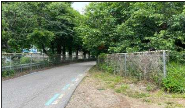
<ASF울타리 중복 설치>
