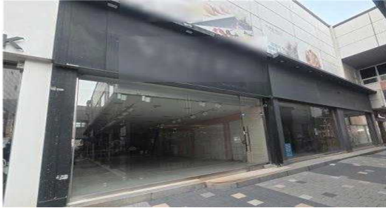
☆☆ 집단상가 1층 현황
