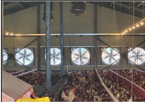
환기시설 설치 지원
