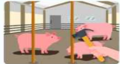
축사는 보조기둥, 버팀목 미리 설치
