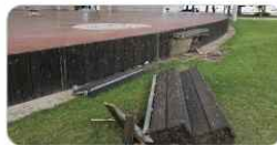
축제장 시설 파손
