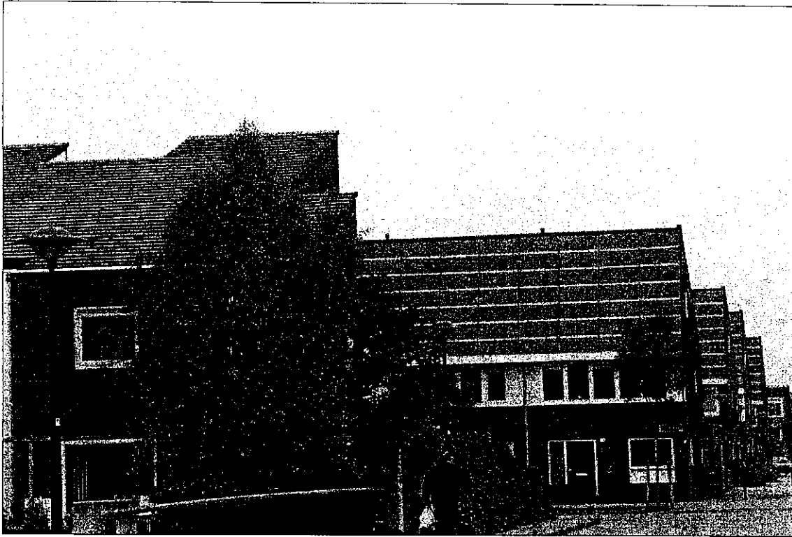
그림7 건물일체형 태양광설비(I)
