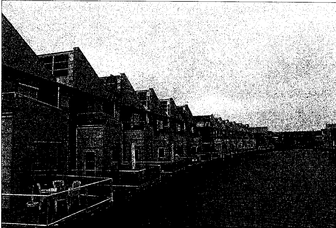
그림5 지면에 수직으로 설치한 태양광설비(II)
