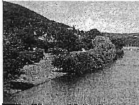
자연형 수변공간 조성 (하이델베르크, 독일)
