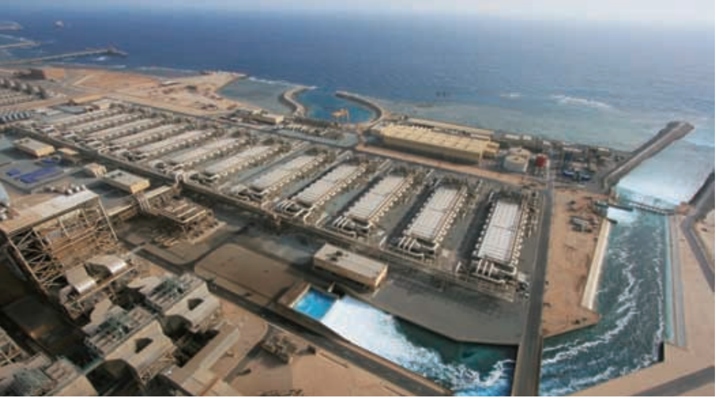
두산중공업이 지난 2010년 건설한 사우디아라비아 쇼아이바의 해수담수화플랜트 전경
